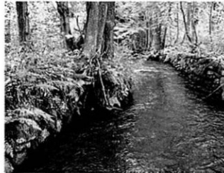
Mit verfallender Natursteinmauer verbauter Mühlgrabenabschnitt (© A. Säuberlich)
